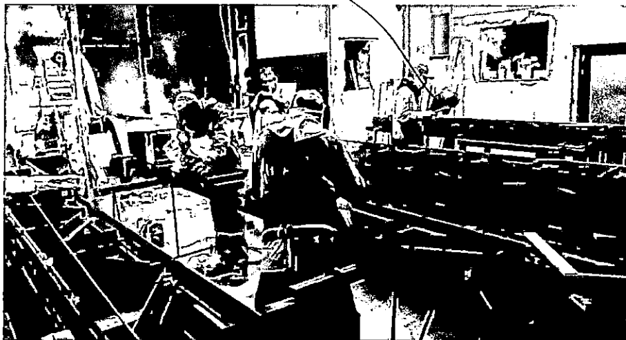
IMAGEN 01 Trabajos de soldadura de la plancha de fijación al tubo metálico de 4".
